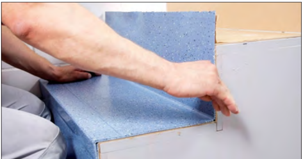
Setzstufen ankleben ...
