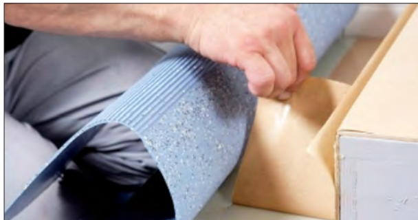
Abdeckpapier entfernen und Trittstufe einlegen.
